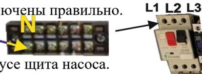
**Заземление** на всех насосах подключается к клемме на корпусе щита насоса.
